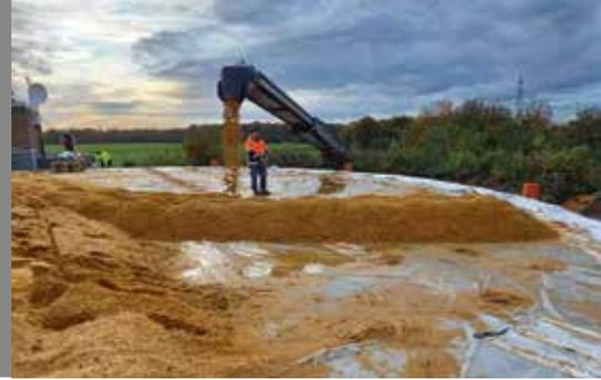
Die neue Drainageschicht wird auf die Betondecke aufgebracht
